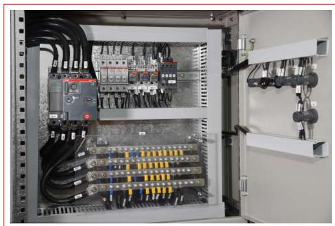
Los módulos pueden destinarse específicamente a la colocación de barras de cobre, fusibles, contactores, borneras y otros componentes, lo que **permite una organización interna optimizada y adaptable a cada requerimiento técnico.**
